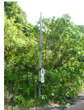
敷地内電気引込柱及び配電盤
